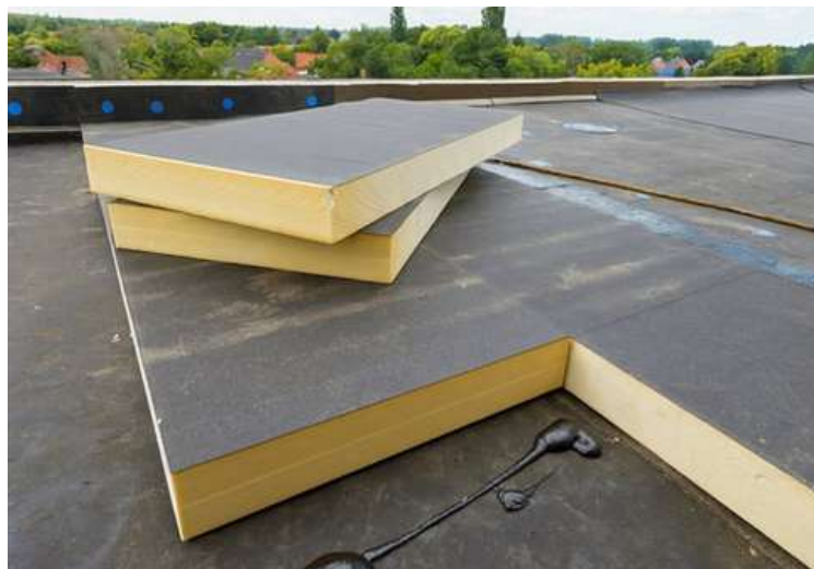
Imatge 26. Addició de panells aïllants en una teulada plana. Font: enllaç .
