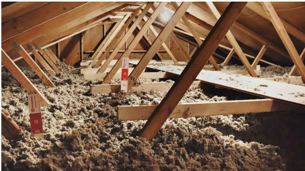
Imatge 8. Addició d'aïllament a l'àtic sota coberta inclinada. Font: enllaç .
