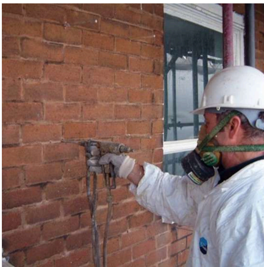
Imatge 6. Injecció d'escuma aïllant en una paret de maó. Font: enllaç
