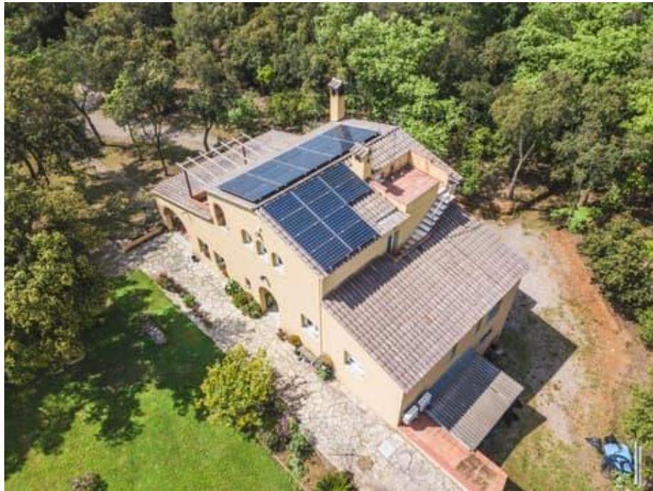
Figura 5. Instal·lació fotovoltaica al terrat d'una casa de Sant Gregori. (Font)
