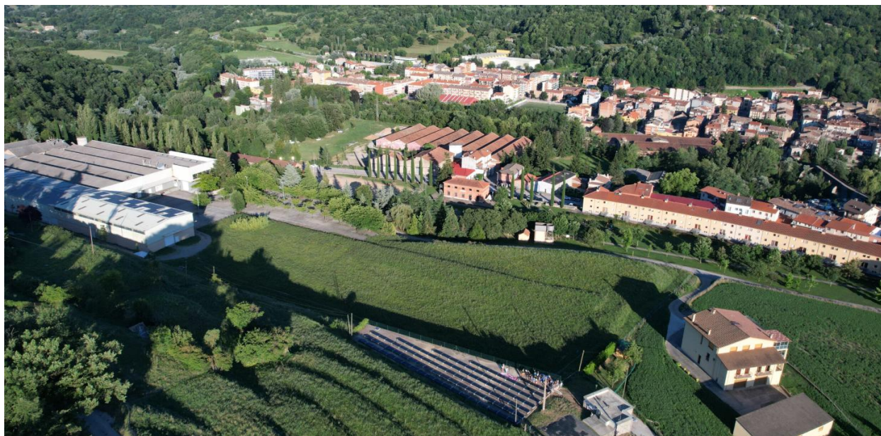
Figura 4: Instal·lació compartida d'autoconsum fotovoltaic amb compensació simplificada de l'excedent a la teulada del dipòsit municipal d'aigua (Font).
