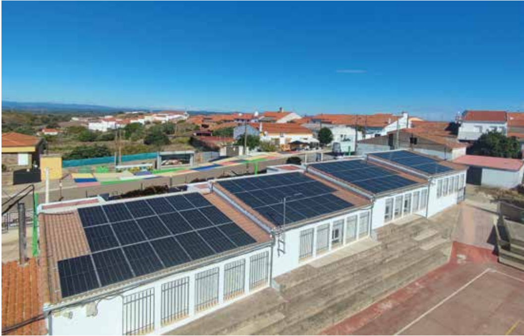
Instal·lació fotovoltaica d'autoconsum col·lectiu sobre escola municipal
