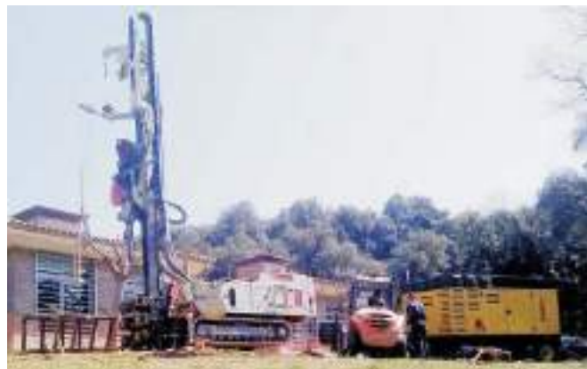
Perforació del camp de captació
