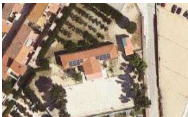
Imatge 10. Instal·lació actual al CEIP Antoni Balmanyà.
