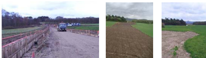
Foto 7 – Línia de MAT Newby - Nunthorpe en rasa i zona rural (Anglaterra). Durant les obres, just després i 18 mesos passat el final de les obres Font: [17].
