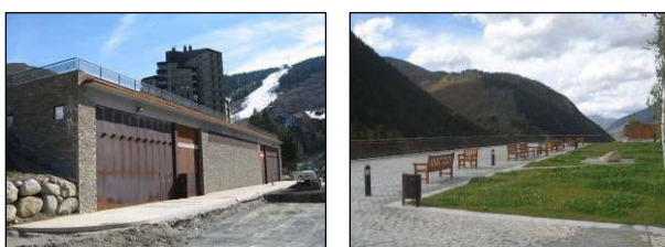
Foto 3 – Subestació de Baqueira (Endesa) a la Vall d'Aran situada als peus de les pistes d'esquí i perfectament integrada. Font: JT08 CIGRÉ
