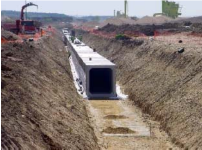
Construcción de la galería.
